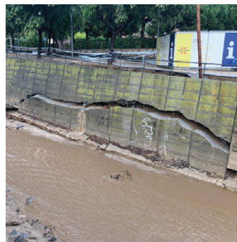
Part del mur esquerdat
