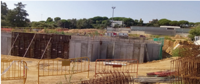
Una imatge de les obres del pavelló
