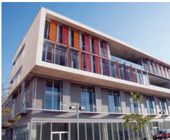
Les obres les va executar FCC però GPO en va fer la direcció
