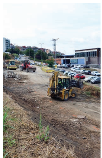
Excavadora al Sorral
