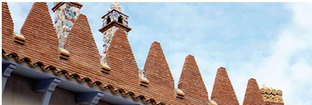
La Casa Puig i Cadafalch rehabilitada
