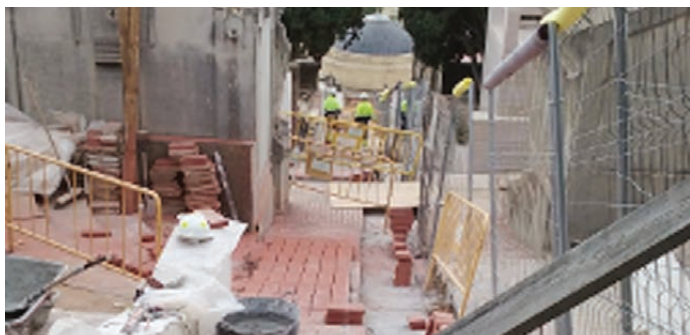
L'escalinata en obres al cementiri
