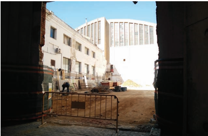
Les obres a la pista del Casal de Joves.
