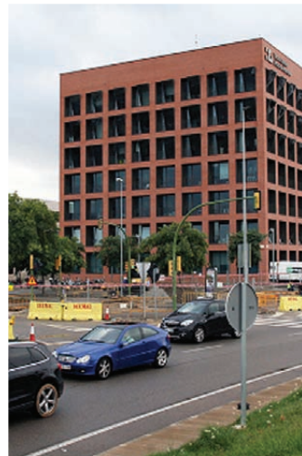
Les obres al TCM
