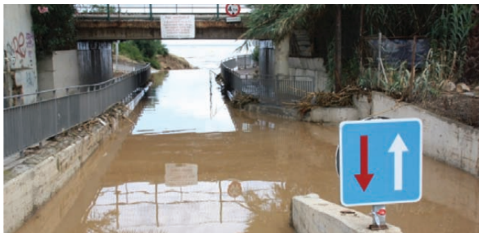
El pas subterrani de Cabrera de Mar inundat per les pluges ACN
