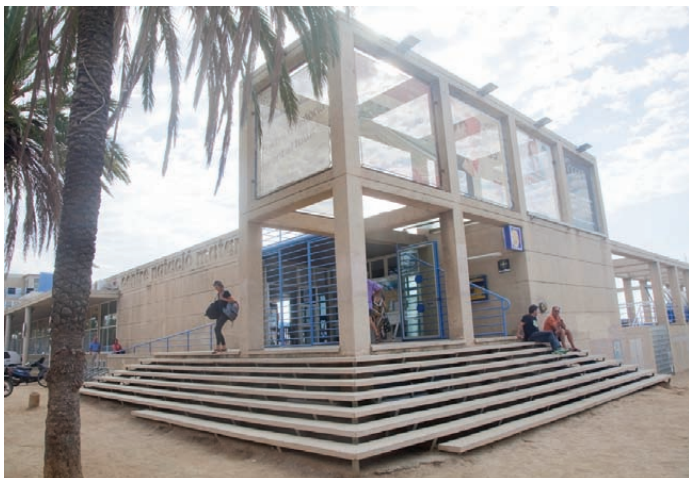
Les instal·lacions del Centre Natació Mataró
