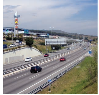
Operaven a l'autopistes
