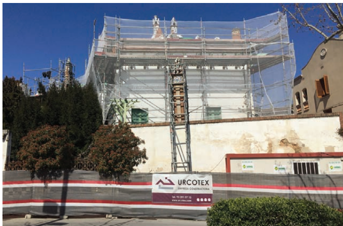
Les obres de la casa d'estiueig de Puig i Cadafalch
